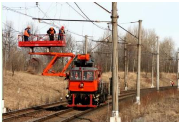
Рисунок 2.10. Выполнение работ по ремонту контактной сети
